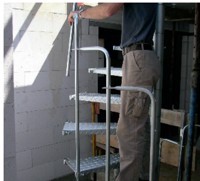
Geländerstäbe einfädeln und in Stufe stecken
