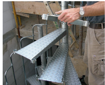
Stufen werden auf die Stufenhalter aufgesteckt
