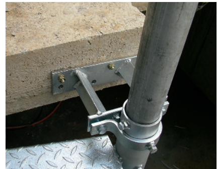
Spindelrohr mit Distanzhalter an der Deckenkante
