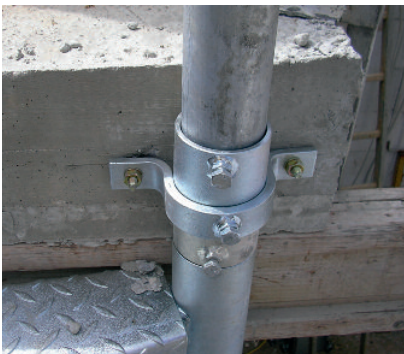
Rohrschellenbefestigung des Spindelrohrs ohne Distanzhalter
