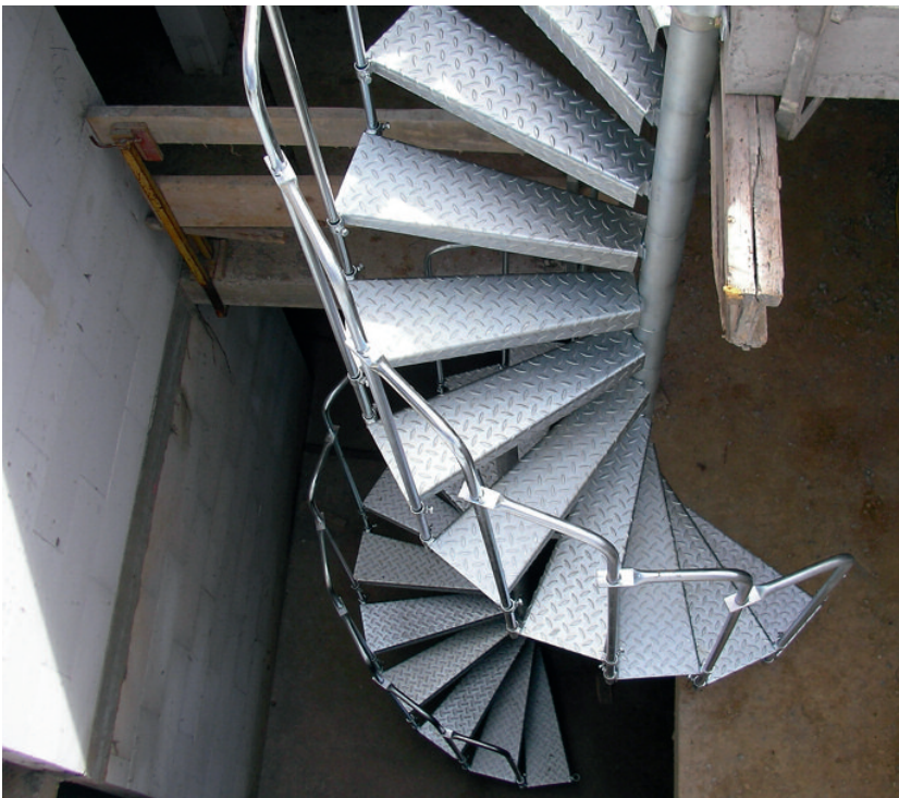
2 Geschoß Bautreppen fertig eingebaut von oben
